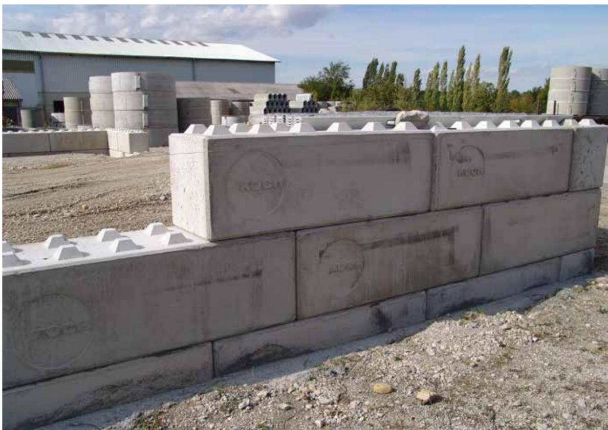
Die Betonprodukte für den Bau von Kompostanlagen werden durch den Varioblock ergänzt, der im Lego-System ganz einfach zu Lagerboxen oder Trennmauern zusammengesetzt werden kann. Ein teures Fundament kann entfallen, es kann direkt von einer befestigten Fläche weggearbeitet werden. Mit einem Radlader oder Lkw-Kran wird in kürzester Zeit Stein für Stein das neue Kompostlager errichtet.
